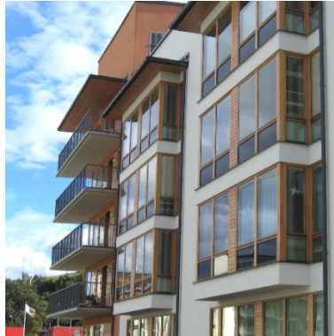
Fönster och Fönsterdörrar
