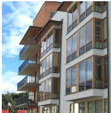
Fönster och Fönsterdörrar
