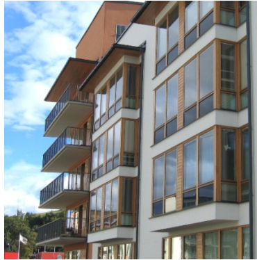
Fönster och Fönsterdörrar
