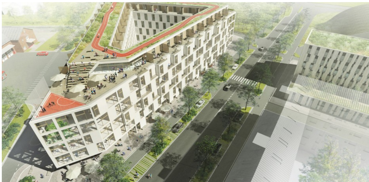
Inspiration Rosendal, Leverans av fönster och entrépartier i sibirisk lärk .
