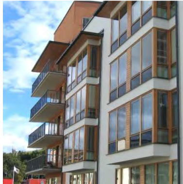
Fönster och Fönsterdörrar
