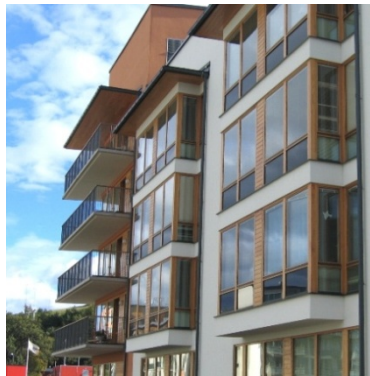
Fönster och Fönsterdörrar
